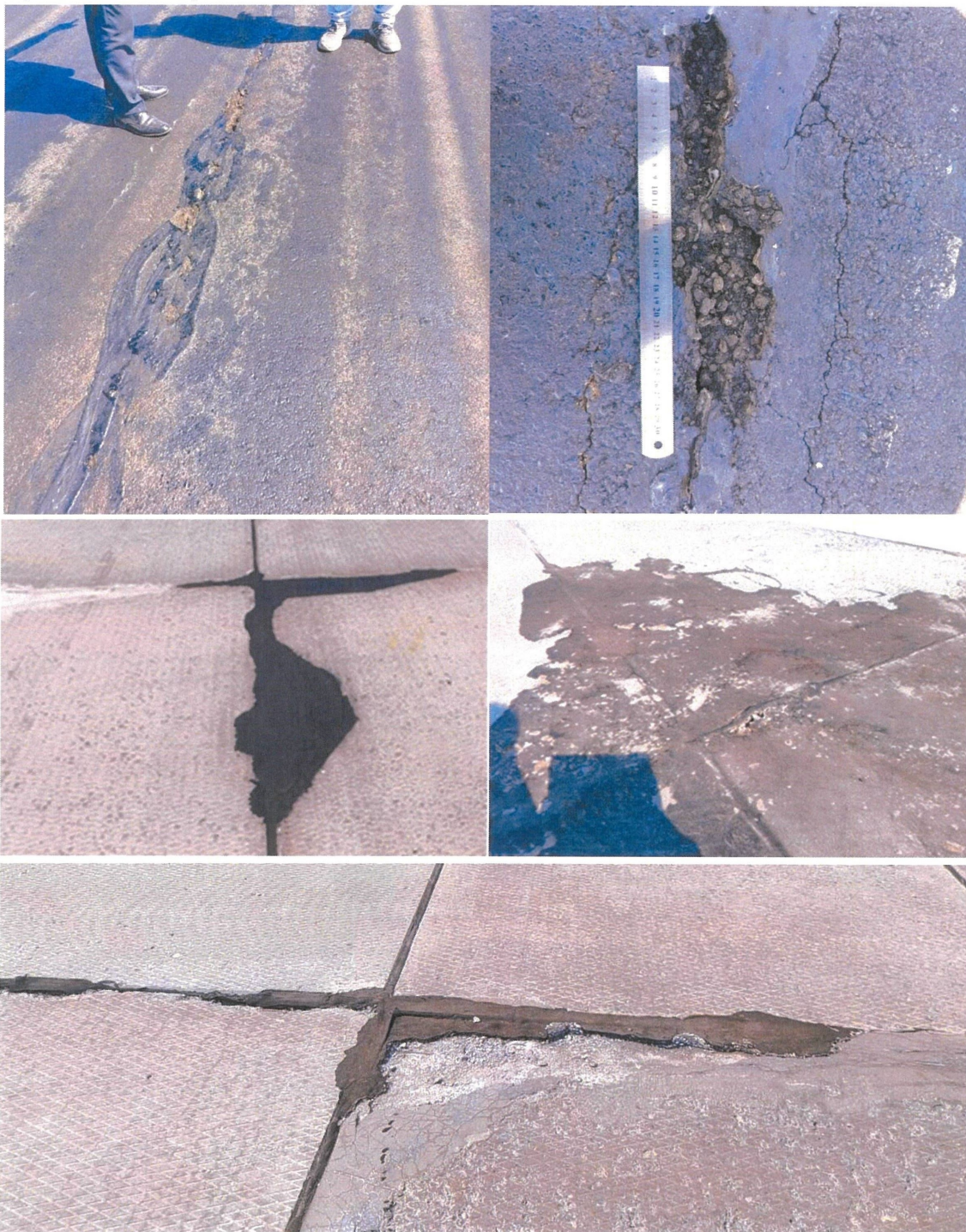
Рис. 1: опыт использования битумных вяжущих в качестве ремонтного материала и пропиточного состава на аэродромах РК
